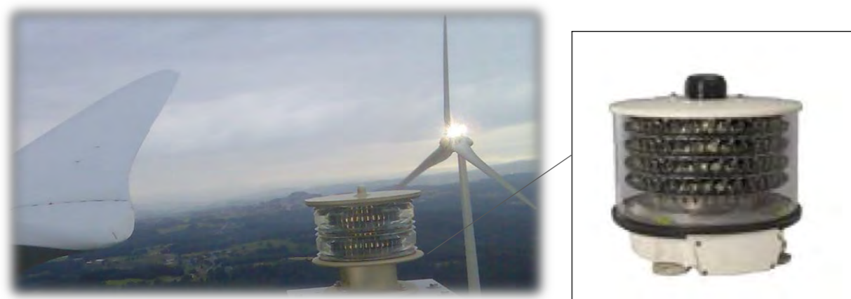
Figure 19 : Balisage d'une éolienne
